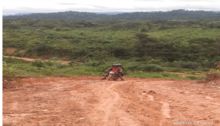
Gambar 1. Kondisi Infrastruktur Jalan Menuju Kampung Sejawet
